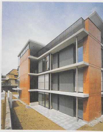
1 Die rot lasierten Betonscheiben prägen die Strassenseite. Hier wechseln sich die Glasfronten mit den dunkelgrauen Eternitpaneelen ab. Fotos: Ferit Kuyas
