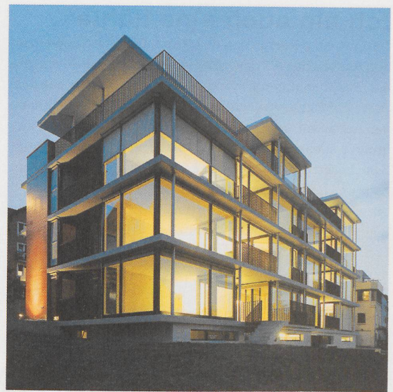
1 Die rot lasierten Betonscheiben prägen die Strassenseite. Hier wechseln sich die Glasfronten mit den dunkelgrauen Eternitpaneelen ab. Fotos: Ferit Kuyas
