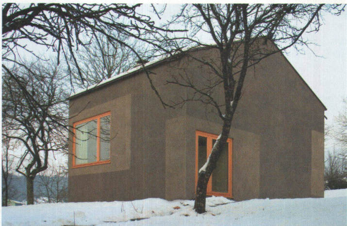
1 An jeder Fassade gibt es nur eine Öffnung, doch diese zieht das hellere Feld im Fassadenputz um die Ecke.
