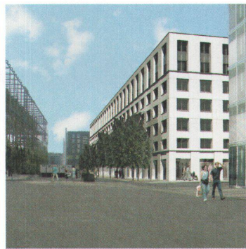
Wohn- und Geschäftshaus Ententeich (im Bau) (24, Seite 13)
