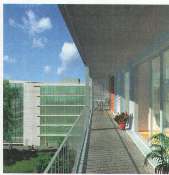
Wohnhaus Parkside (im Bau) (20, Seite 12)
