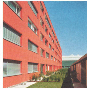
Wohnüberbauung Arnikaahof (8, Seite 12)
