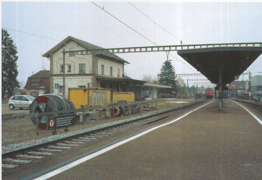
86 Züge halten täglich am Perron von Boswil-Bünzen, doch das ehrwürdige Bahnhofgebäude ist ausrangiert.
