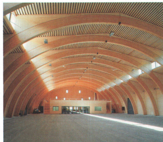
3 Am einen Ende ist die Konstruktion scharf abgeschnitten und die Wand zurückgesetzt. So entsteht ein gedeckter Vorplatz für Mensch und Vieh. Fotos: Ralph Feiner
