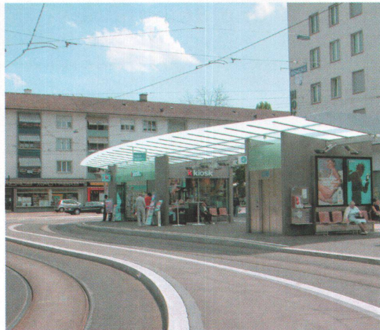
2 Da die Tragkonstruktion über der Glasfläche liegt, wird die matte Fläche zu einem filigranen Schirm.
