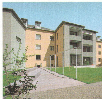
Sanierung MFH Schaffhauserstrasse 60
