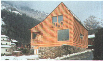
Einfamilienhaus Stiege, 2003 Bürglen
