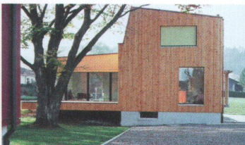
Wohnen und Atelier, 2005 Rickenbach --> Bauherrschaft und Architektur: Ursula Habermacher und Richard Kretz, Luzern --> Holzbau: Burch AG, Sarnen
