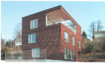
Einfamilienhaus, 2004 Landschaftsstrasse, Luzern --> Bauherrschaft: Daniel Von Arx und Claudia Steiner Von Arx, Luzern --> Architektur: Andreas Rigert und Patrick Bisang, Luzern --> Holzbau: Burch AG, Sarnen
