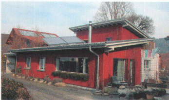
Einfamilienhaus, 2003 Müli, Altshofen --> Bauherrschaft: Marlis & Otto Hunke- ler Kaufmann, Altshofen --> Projekt: Marlis & Otto Hunkeler Kauf- mann; L & B Architektur, Altshofen --> Holzbau: Lang Holzbau, Altshofen
