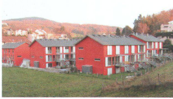
Minergie-Holzbau-Siedlung, 2004 Im Winkel, Affoltern am Albis
