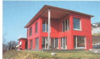
Einfamilienhaus, 2003 Büron --> Bauherrschaft: Anita und Theo Bühlmann, Büron --> Architektur: Franz Amberg, Sursee --> Holzbau: Franz Häfliger Holzbau, Büron
