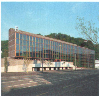
BBB Neubau Bruggerstrasse, 2006 39
