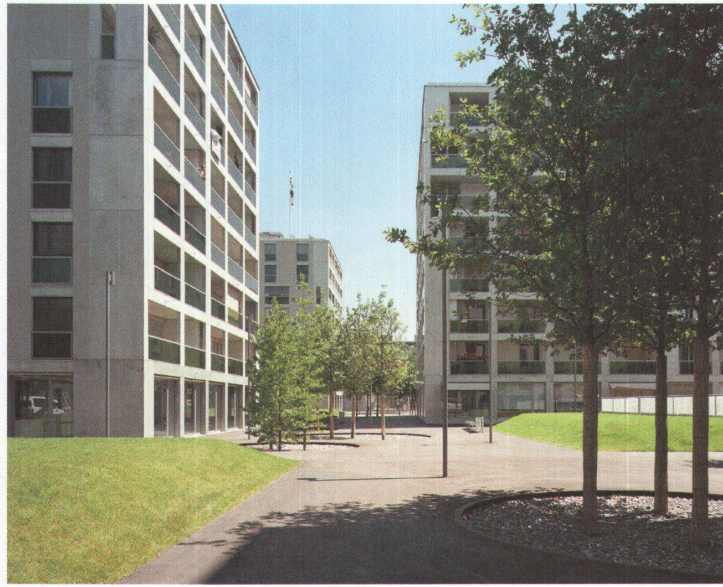
1 Nicht Abstandsgrün, sondern ein städtischer Raum liegt zwischen den Wohnhäusern im Werdwies. Foto: Georg Aerni
