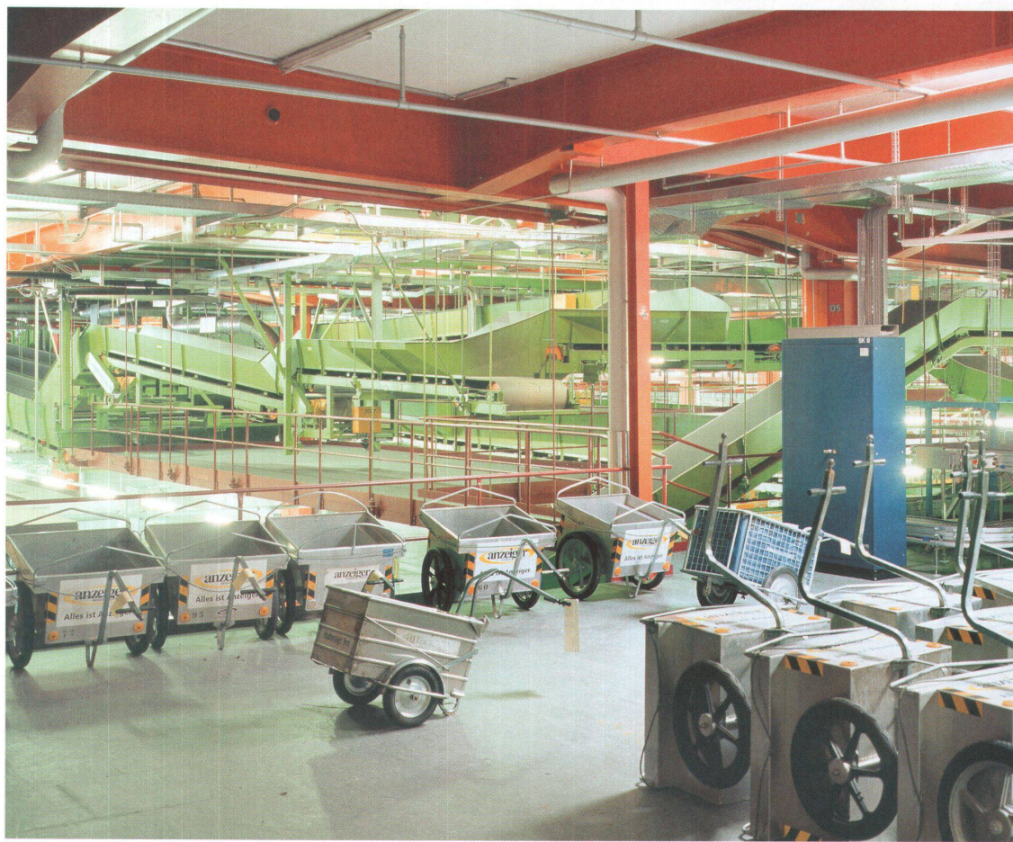
1 Die Förderanlagen im alten Paketzentrum Schanzenpost warten auf die Demontage; demontiert wird später auch das Gebäude.
