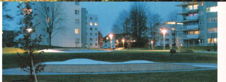
> Die Tiefgarage musste entlastet werden: weg mit dem schweren Humus, hin mit Spielplatzflächen.
