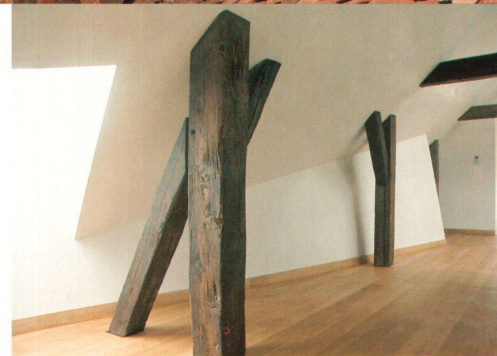
^ Roh gegippte Flächen decken die Dämmung ab, dazwischen stossen die Balken hervor.
