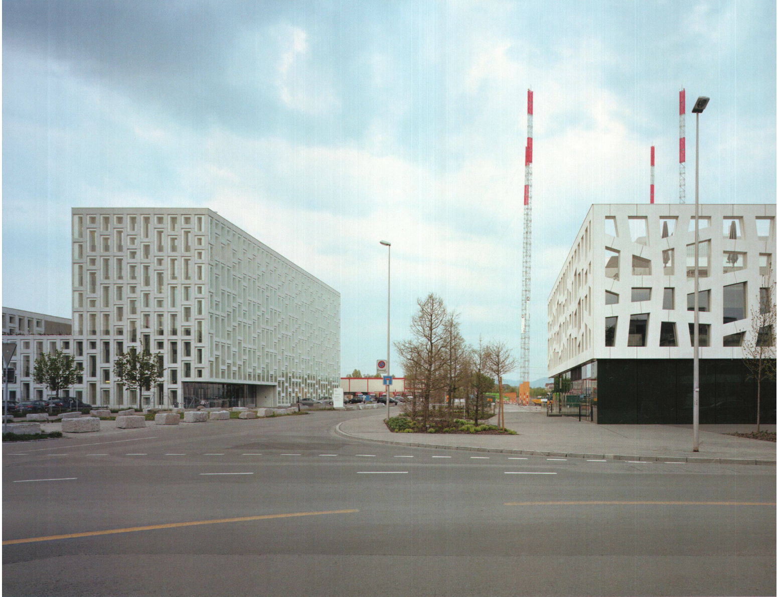
^ Einfahrt ins Areal von Roche Diagnostics in Rotkreuz, gerahmt vom Kundenzentrum (links) und vom Personalrestaurant (rechts).
