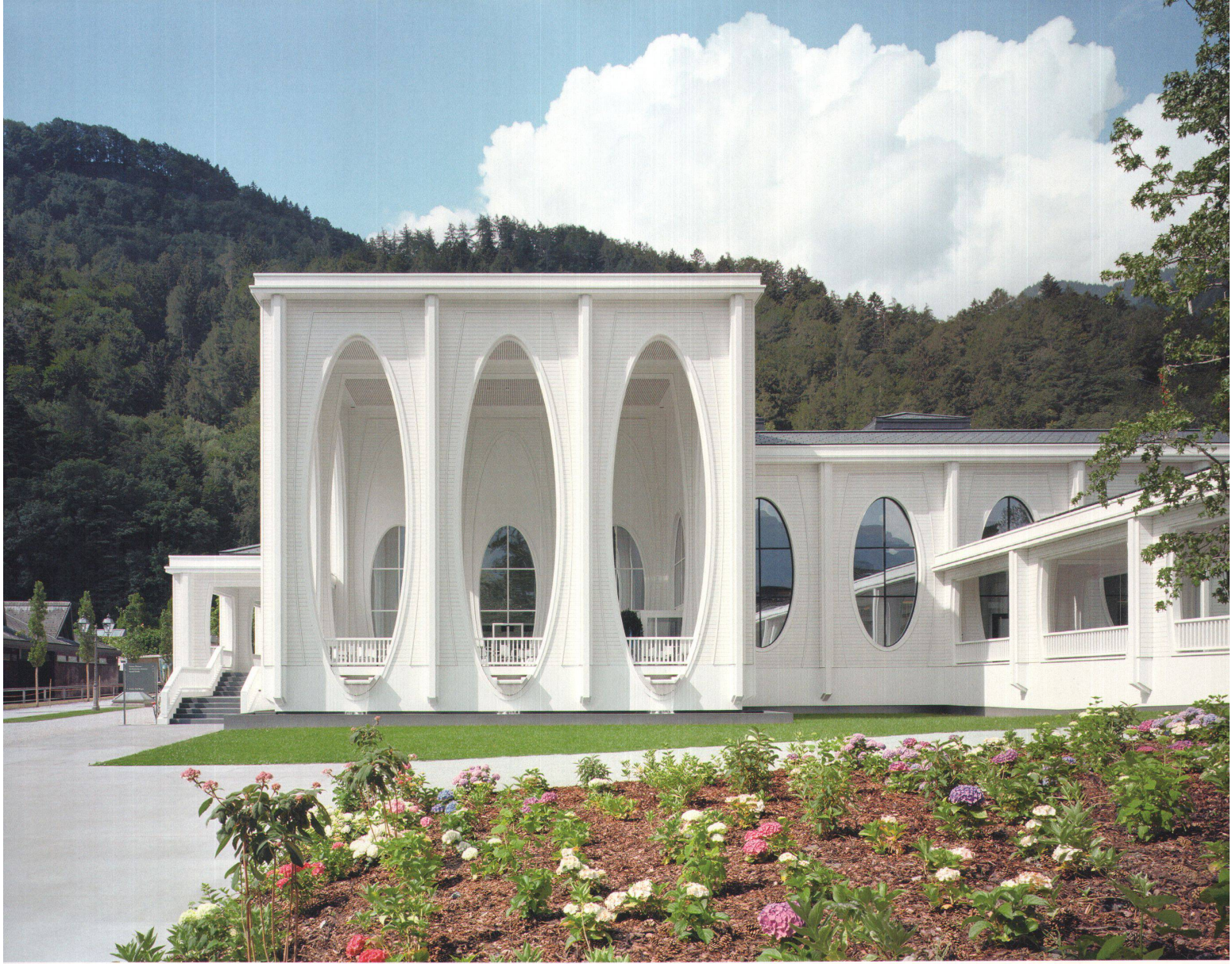
^Die Quellenhalle ist das weitwirkende Merkzeichen und sagt: Hier!
