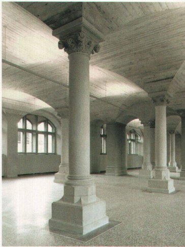
^Das sanierte Gewölbe im Erdgeschoss wurde zu «Galerie Sammlungen». Foto: Roman Keller
