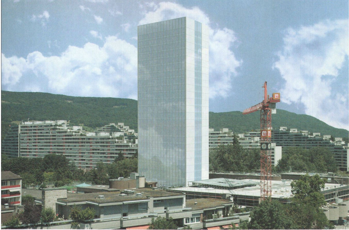
^6_ Erneuerung Gebäudehülle Telli-Hochhaus
