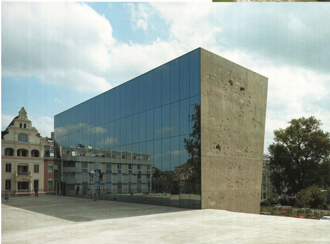
<3 Historisches Museum: Das Dach des grossen Ausstellungssaals ist ein Platz, der dem ganzen Museum dient. Hinter der Glasfassade liegen auf vier Geschossen die Büros.
