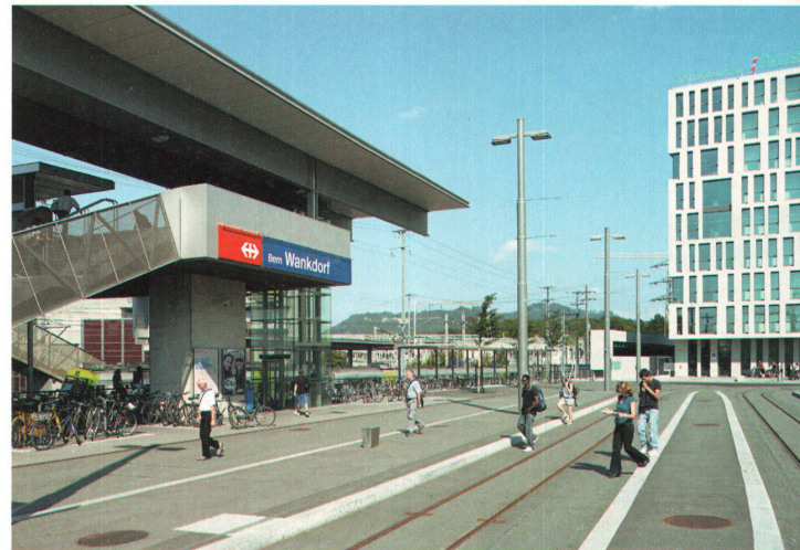
^6 Max-Daetwyler-Platz: Auf dem Platz zwischen der S-Bahn-Station und dem Bildungszentrum liegen schon die Schienen für das Tram 9. Ab 2012 wird es hier wenden.
