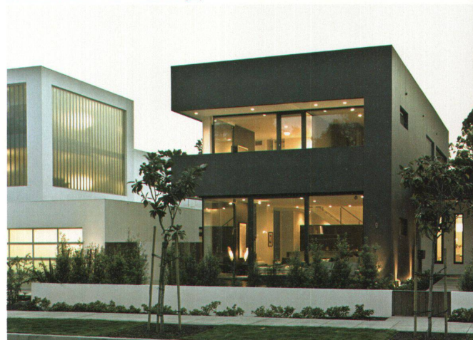
↳ Die Makineni Townhomes in Long Beach von Roger Kurath bestehen aus vorgefertigten Betonelementen. Fotos: Robert Gregory
