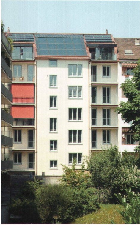
^Die Hälfte des Treppenhausturms auf der Hofseite ist nun ein «Zimmerturm».
