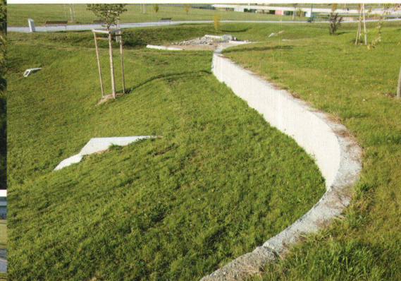
∨ Die Mauer aus Stampfbeton grenzt den Park von der Siedlung ab.
