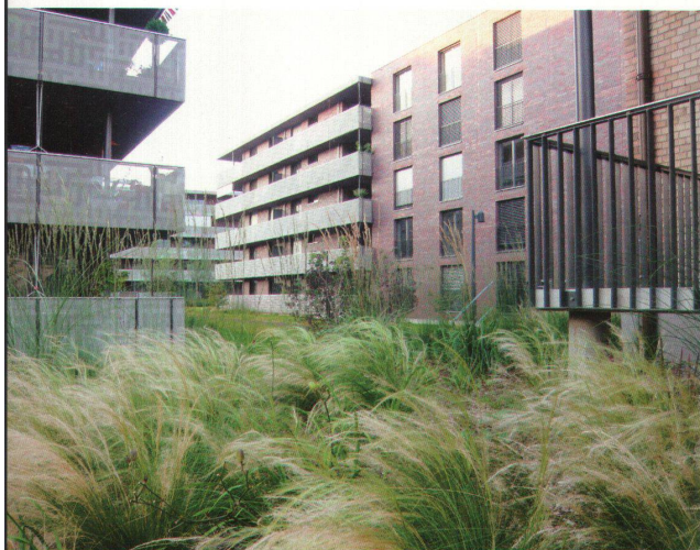
<Die Wohnhäuser im südlichen Arealteil sind in Grünräume aus feinen Gräsern eingebettet.
