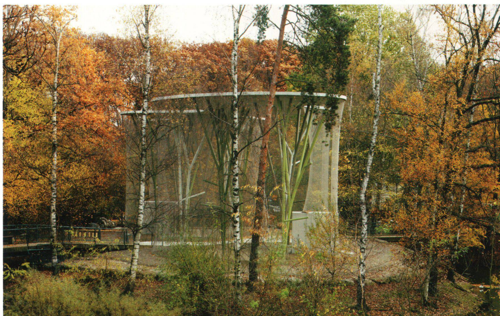
^ Stählerne Bäume im Bois de la Bâtie: die fast unsichtbare Volière.
