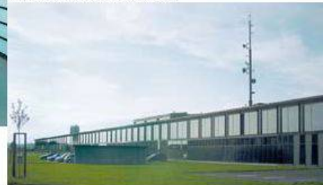
∨5_ Centre d'entretien des routes nationales, Bursins.
