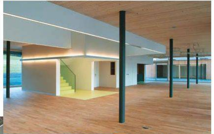
v23_Swissgenetics, Zollikofen: sichtbare Brettstapeldecken. Fotos: Pascal Hegner
