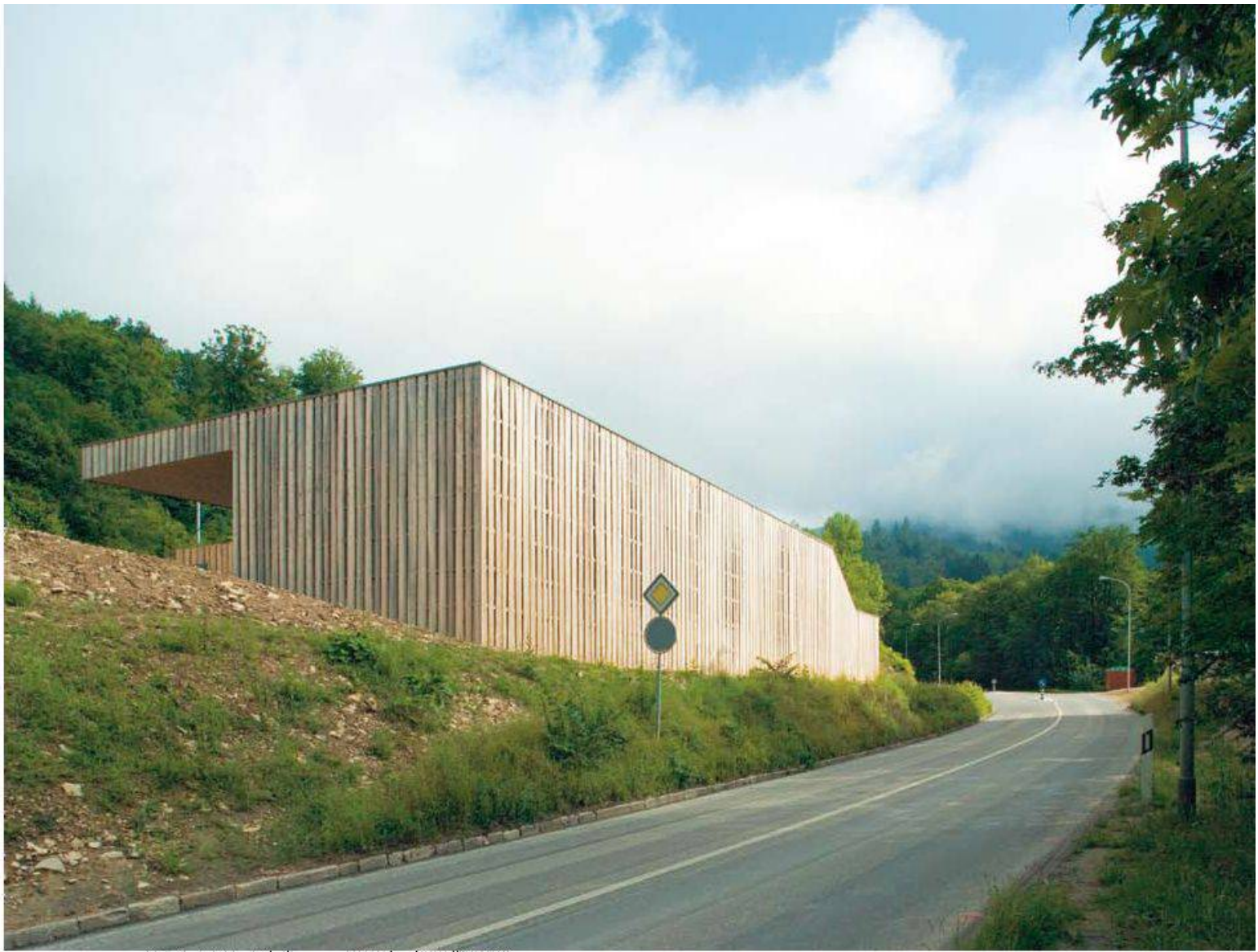
^21. Das Werkgebäude verkleiden sägerohre, vergrauende Weisstannenbretter.
