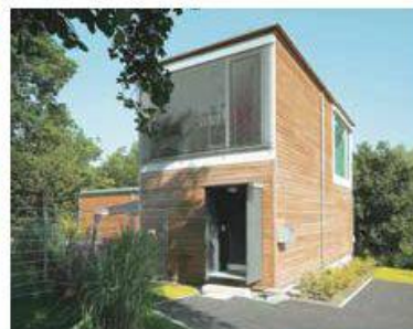
◀28_Wohnhaus in Elementbauweise, Campingplatz Eichholz, Bern: effizienter Holzsystembau.
