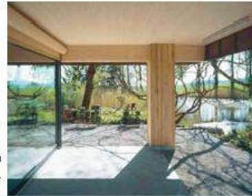
➤ 55_Sommerhaus: einer von acht massiven Lärchenpfählern.
