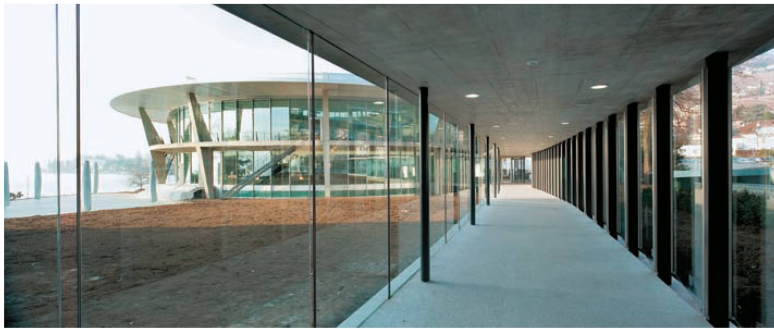
>Eine gläserne Passerelle – mit Aussenklima – verbindet das Tschumi-Gebäude mit dem Neubau.
