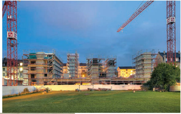
^Die Badenerstrasse 380 im Rohbau, Sommer 2009. Eine sechsgeschossige Holzkonstruktion zwischen Blockrand und Stadtpark.
