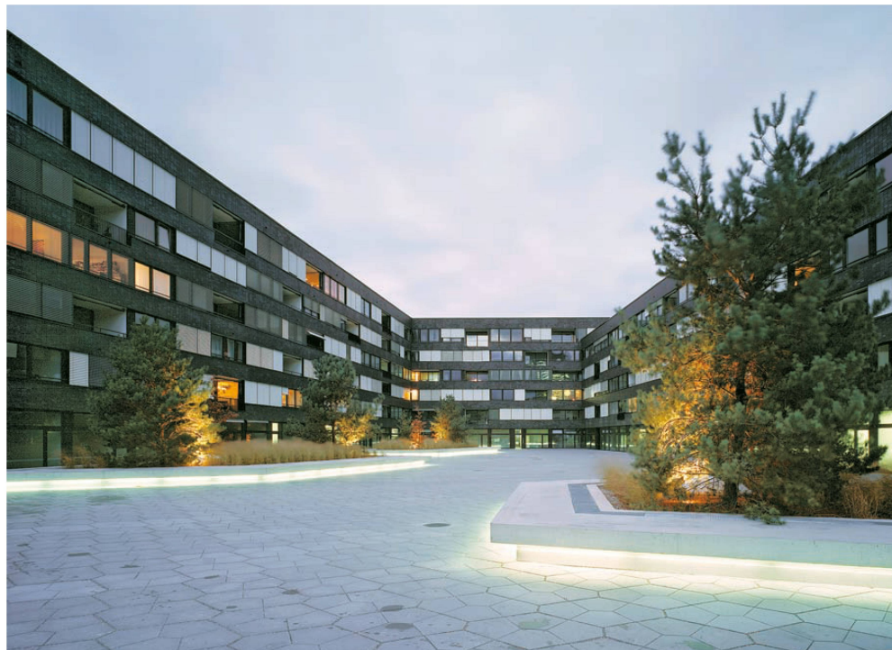
^Vorgehängter Klinker, helle Jalousien: eleganter Kontrast der Fassaden im Eingangshof auf der Stadtseite.
