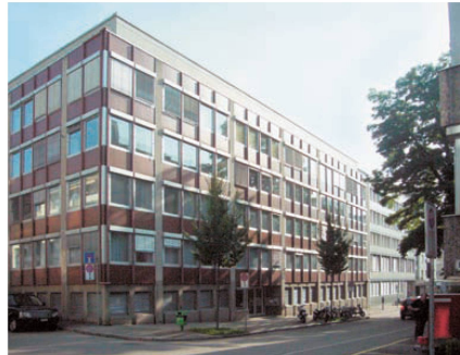
>Geschäftshaus vor der Sanierung.
