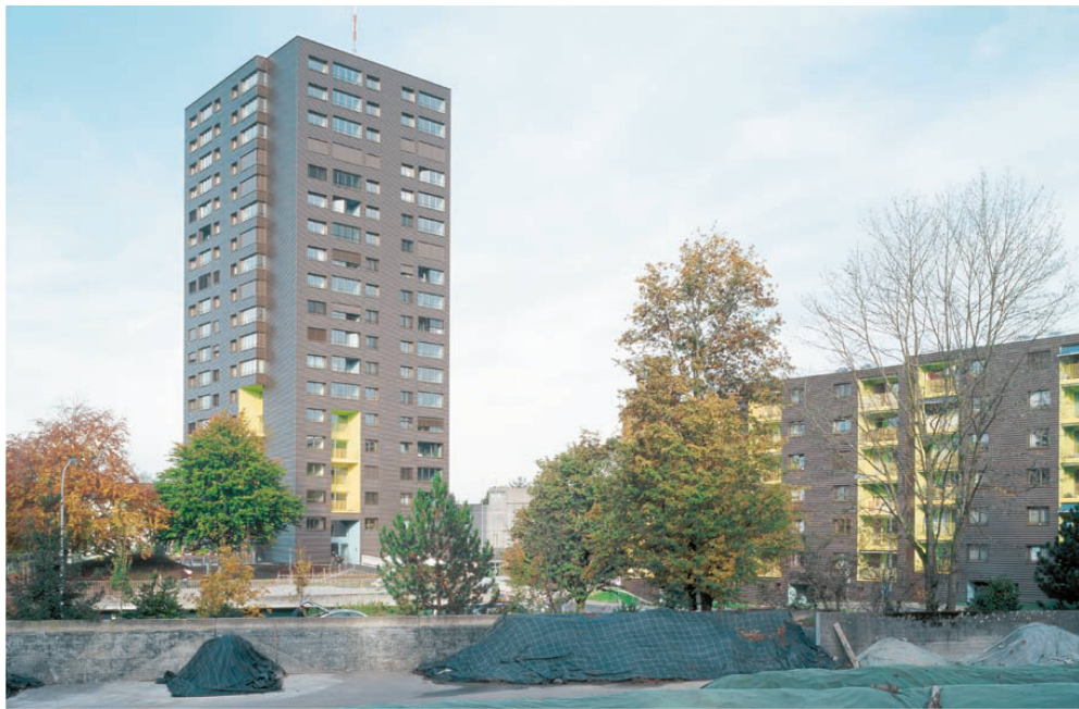
^ Saniert und dick eingepackt: die Siedlung Heumatt in Zürich-Seebach.
