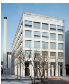
<2_ Bürogebäude auf dem Basler Novartis Campus von Vittorio Magnago Lampugnani.
