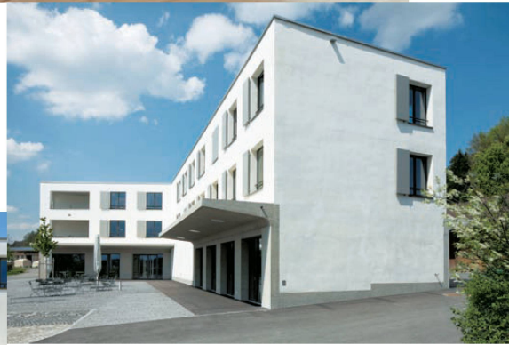
>Das Wohnheim Mettmenstetten fasst einen öffentlichen Platz.
