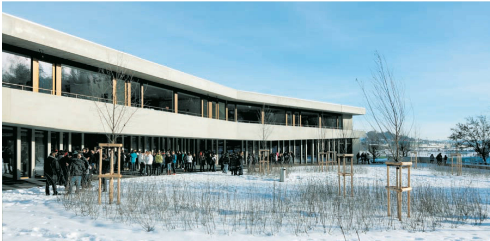
^Das breite Brüstungsband ist auch Fluchtweg.
