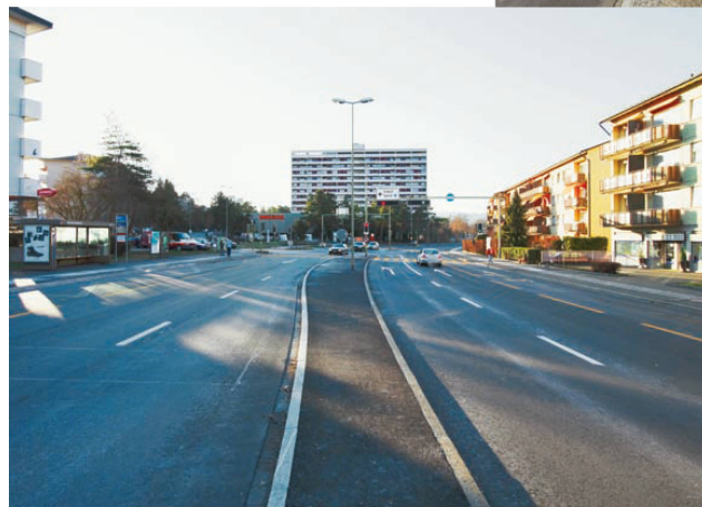
^Sanierte Badenerstrasse Blick Richtung Westen. Der Bus hat seine eigene Spur bekommen.
