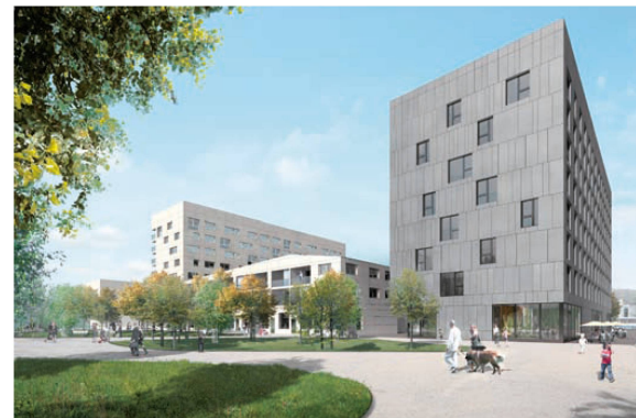
^22_Der dunkle Neubau Brandstrasse 29-31 (Baufeld A5) stammt von Novaron Architekten.
