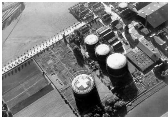
^Die vier Gasbehälter des Gaswerks auf einer Luftaufnahme von 1944. Das Schweizerkreuz signalisierte den Alliierten: Das ist kein deutscher Industriebetrieb!
