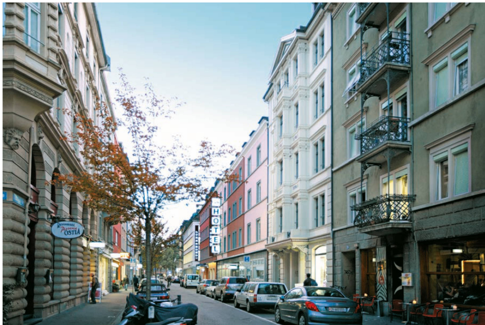
^ Ins denkmalgeschützte Altstadtwohnhaus in Zürich mit dem auffälligen Dreiecksgiebel wurden sieben Luxuswohnungen eingebaut.
