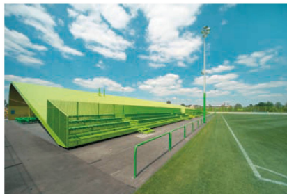
> Das Garderobengebäude wächst aus dem Boden heraus und dient im unteren Bereich als Tribüne.
