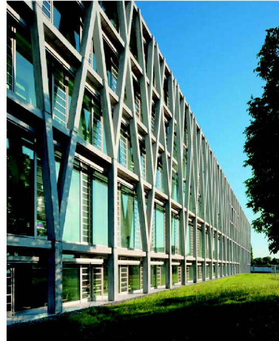
^ Aus Betonelementen zusammengesetzte Bäume bilden das äussere Tragwerk des Schulhauses in Carouge bei Genf.
