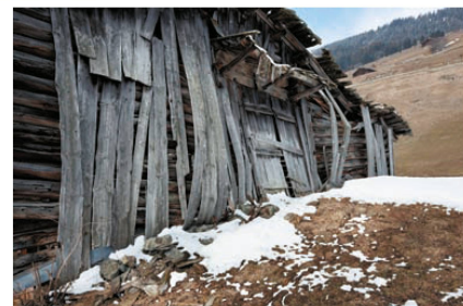
^Längst wird hier kein Heu mehr eingefahren.
