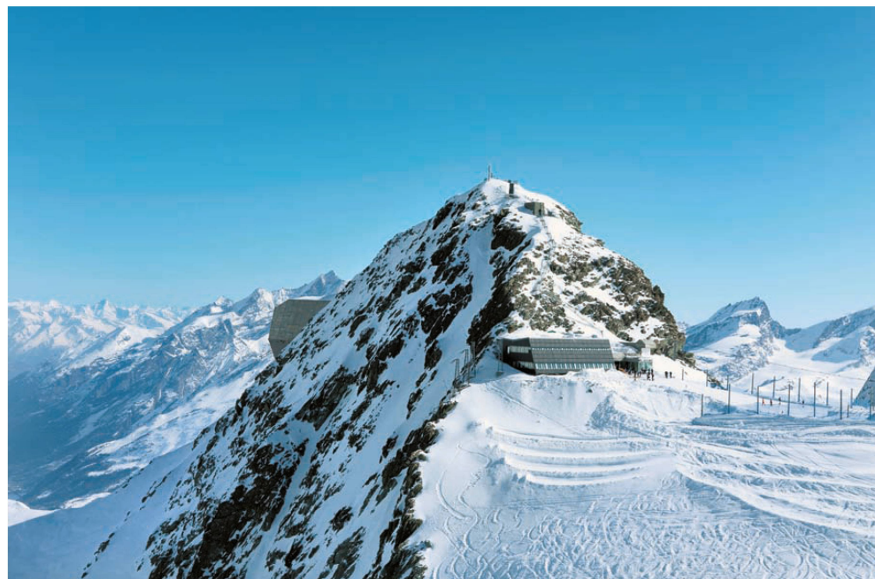
^ Glacier Paradise, 2883 mü. M.: Das Gebäude sonnt seine Fassade und bezieht so seine gesamte Energie.
