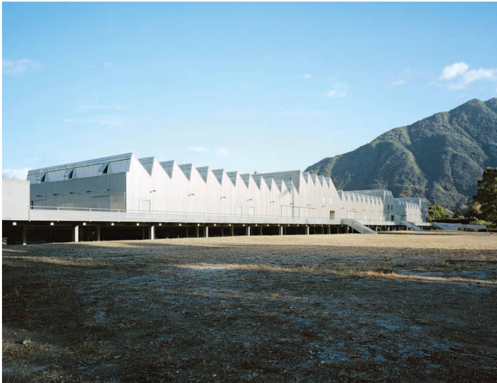
^Fabrik? Schule? Das Ausbildungszentrum in Gordola von Durisch & Noll. Foto: Tonatiuh Ambrosetti
