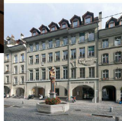
<Die Hauptfassade an der Kramgasse wurde erst nachträglich im Verhältnis eins zu zwei geteilt.
