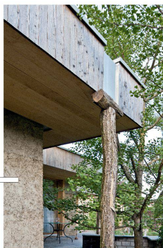
^Viele Ad-hoc-Details zeugen davon: Der Bauherr packte beim Bau mit an.
