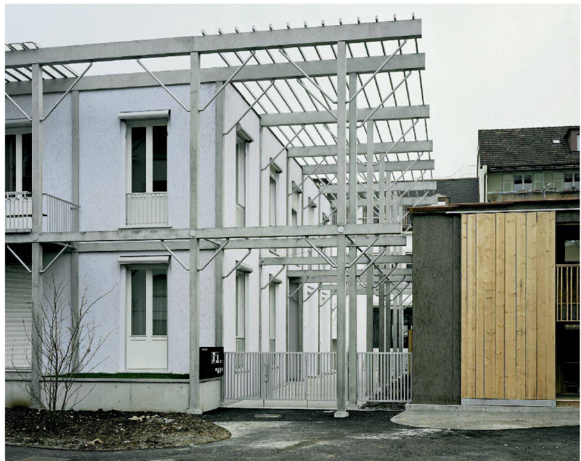
^ Das Gerüst aus Beton und Stahl legt sich wie eine zweite Haut über die gedämmten Aussen- wände. Im Hinterhaus trägt es die Balkone.
