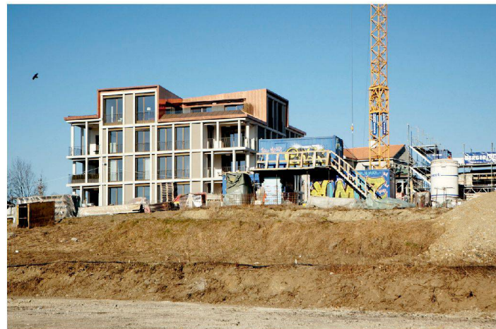
^Der hervortretende Betonraster von «Milano» bindet die Eckkloggien in den Baukörper ein.
