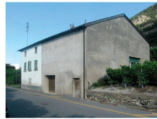
◀ Das Haus im Walliser Dorf Charrat vor dem Umbau.
