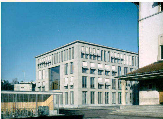
✓8_ Neues Stadtverständnis in Architektur übersetzt: das Stadthaus an der Jona. Foto: Heinrich Helfenstein, Plan: Architekten
