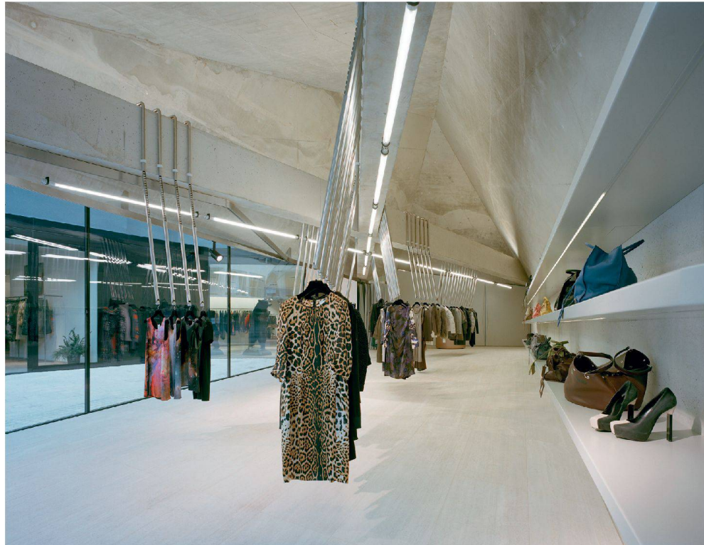
^ An den massiven Betonträgern hängen überdimensionale Haken als Kleiderbügel.
