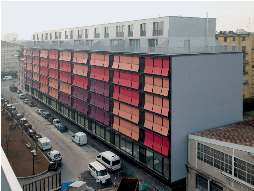
✓Grosse Stoffstoren in drei unterschiedlichen Rottönen beschatten die Fassade und verleihen dem Gebäude den Namen: Koralle.
