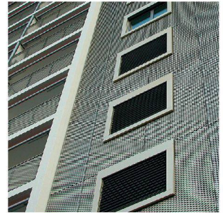
^Geschosshohe Platten aus Streckmetall bilden das Kettenhemd. Foto: Flübacher-Nyfefer + Partner
