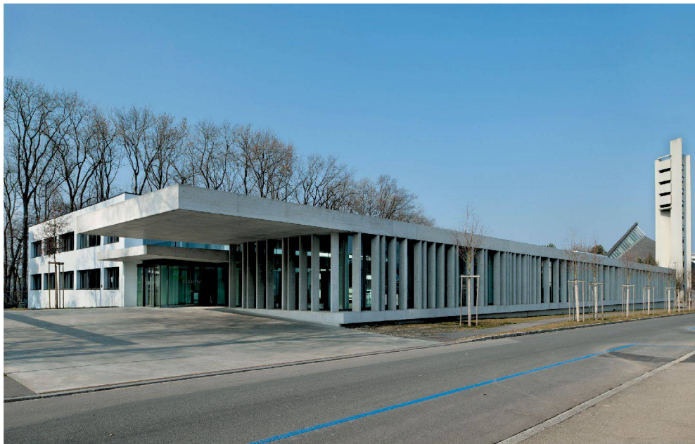
^ Ein Lamellenraster rhythmisiert die Fassade des neuen Längsbaus des Schulheims Rossfeld in Bern. Der Turm scheint das Gebäude abzuschliessen, er gehört jedoch zur Thomaskirche.
