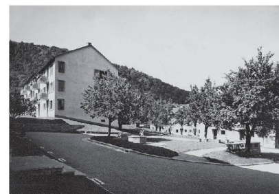
^ 1_ Die abgebrochene Siedlung Triemli in Zürich-Albisrieden.
