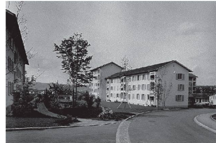
^2_Die abgebrochenen Häuser der Siedlung Albisrieden.
